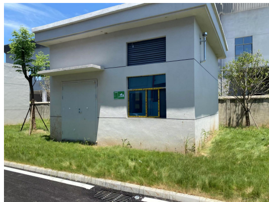
一般固废暂存间
